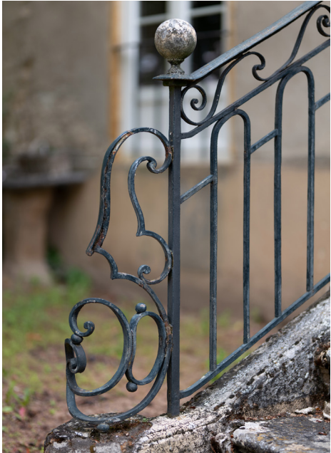
Rampe extérieure, « épingle Louis XV »
