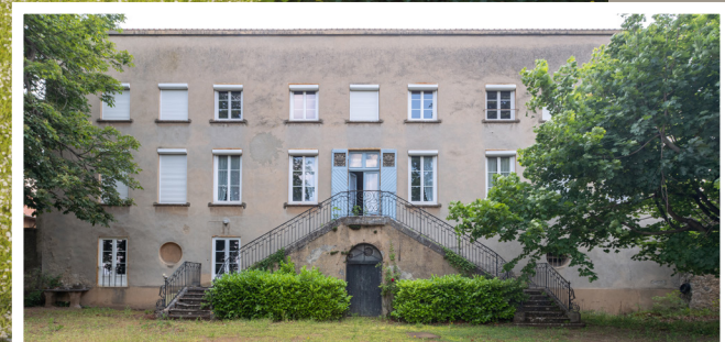
Bâtisse principale avant réhabilitation
